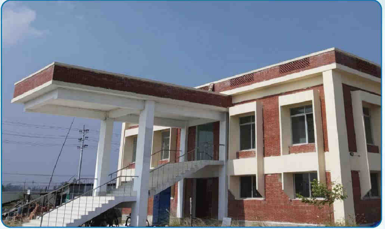
ভাঙ্গুরা ১৩২ কেভি সাবস্টেশন কন্ট্রোলরুম
