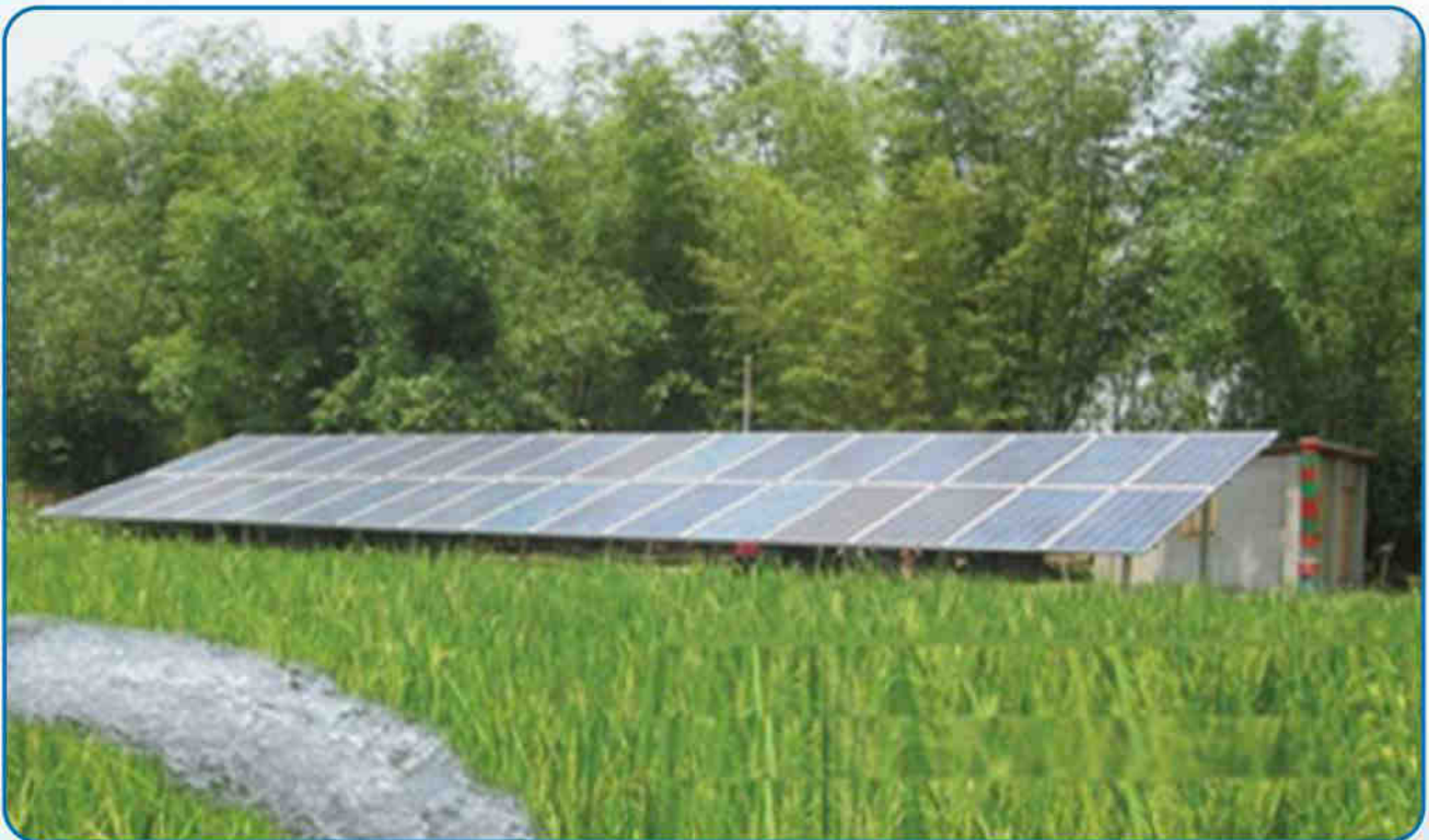
যশোর জেলার মিরপুরে স্থাপিত সোলার সেচ পাম্প
